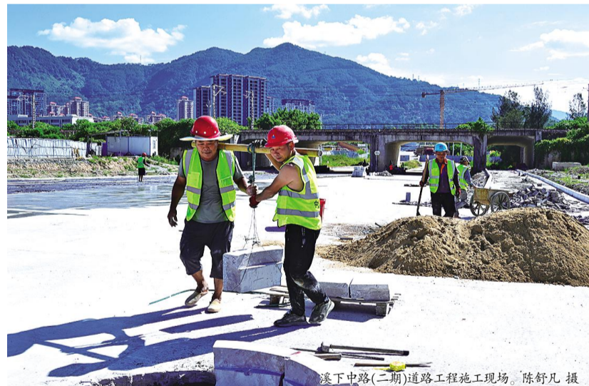
溪下中路(二期)道路工程施工现场。陈舒凡 摄
