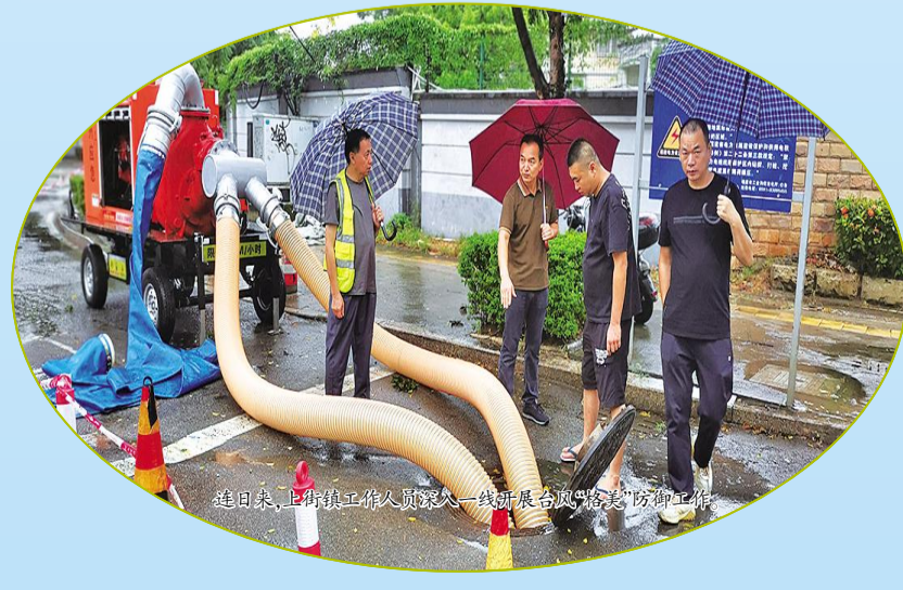
7月24日，甘蔗街道在陈厝湖工业区2号路下穿涵洞安置柴泥机泵，并积极组织人员对排水管道进行接驳、加固。
